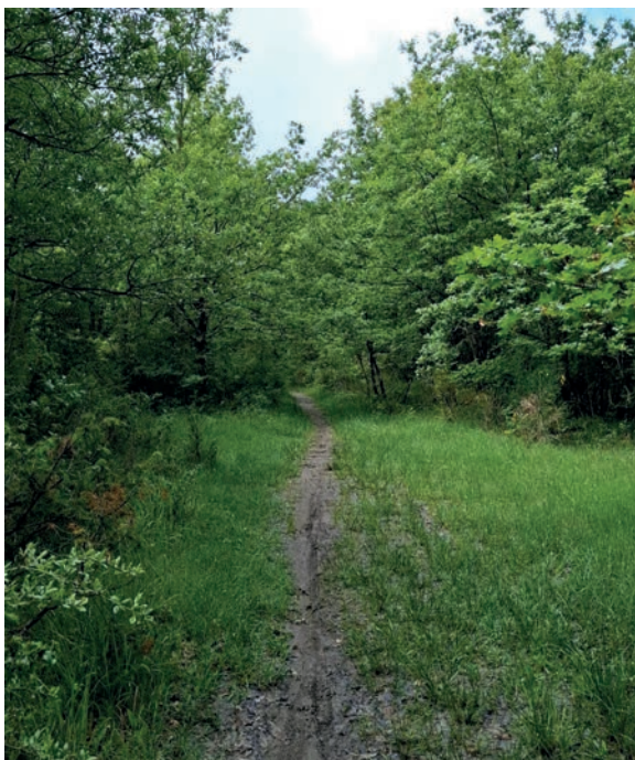
Foto 7: Tracciato forestale non stabilizzato con fondo fangoso e vegetazione densa, riconducibile a pista trattorabile secondaria
