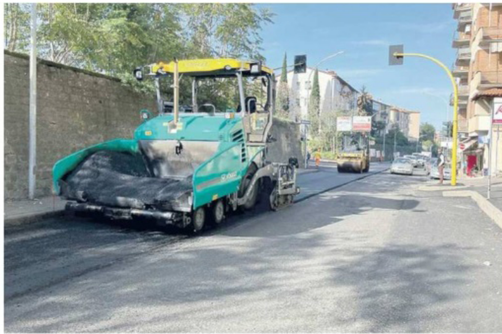
I lavori di asfaltatura in via della Palazzina in prossimità dello stadio Rocchi
